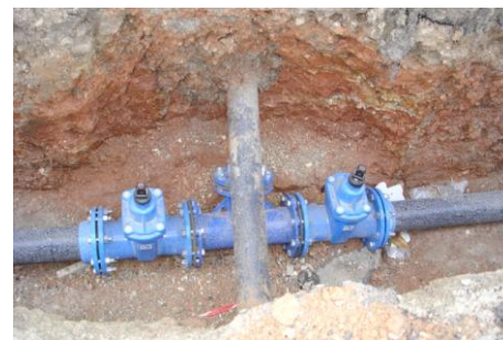
2- Pose d'une nouvelle canalisation d'eau potable
