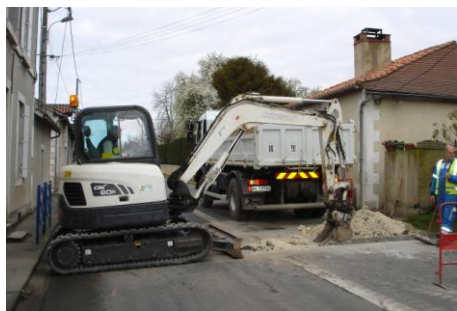
1- Enfouissement des réseaux : mise en place des gaines et câbles électriques, éclairage public et téléphone
