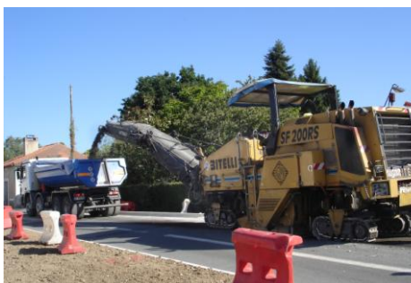
5- Rabotage de la chaussée avant la réalisation des trottoirs et du revêtement
